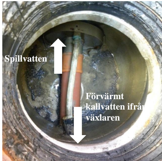
Figur 10: Kopplingar i nedstigningsbrunn B.
