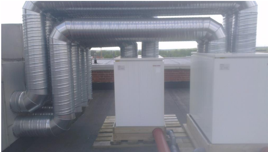
Bild 1: Frånluftsvärmepumpar Västergatan 21.
