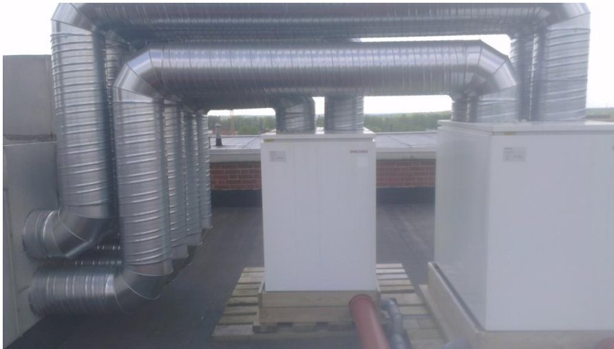
Bild 1: Frånluftsvärmepumpar Västergatan 21.
