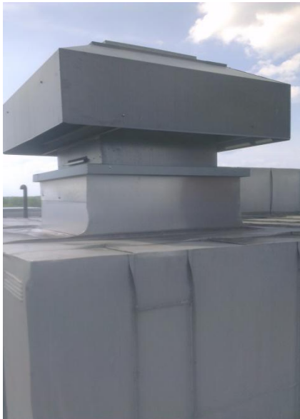
Bild 2: Avluftsdon Västergatan 21. Avluftens temperatur kan enligt uppgift sänkas till cirka -30\text{ }^{\circ}\text{C} , men körs på Västergatan ned till -10\text{ }^{\circ}\text{C} .
