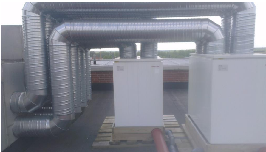
Bild 1: Frånluftsvärmepumpar Västergatan 21.
