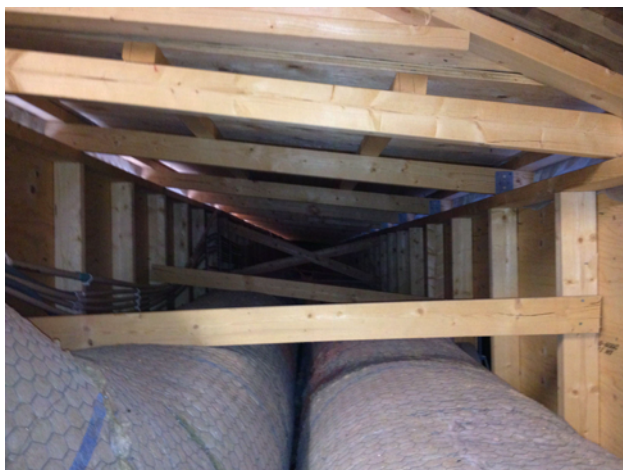
Figur 10. Invändigt placerade huvudkanaler på Höstvågen 22, 2012-04-12
