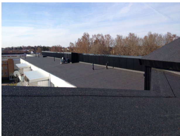
Figur 11. Byggnad runt huvudkanaler på Höstvägen 22, 2012-04-12
