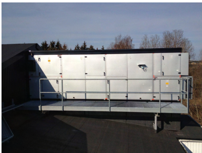
Figur 7. Utvändigt placerat FTX-aggregat på Höstvågen 22, 2012-04-09
