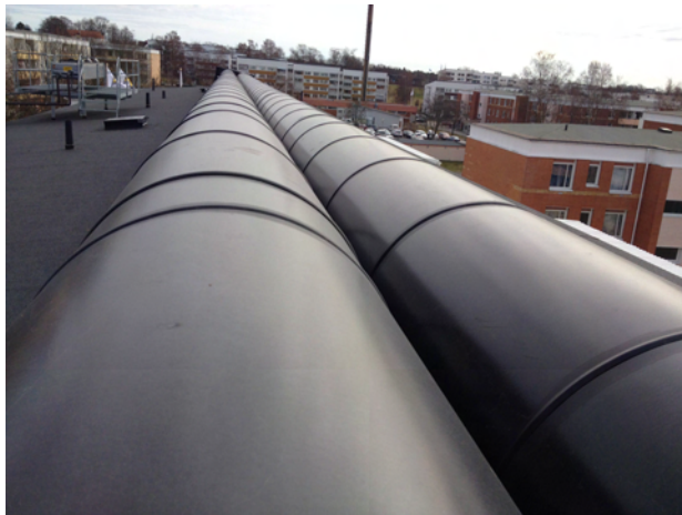
Figur 9. Utvändigt placerade huvudkanaler på Höstvågen 14, 2012-02-17
