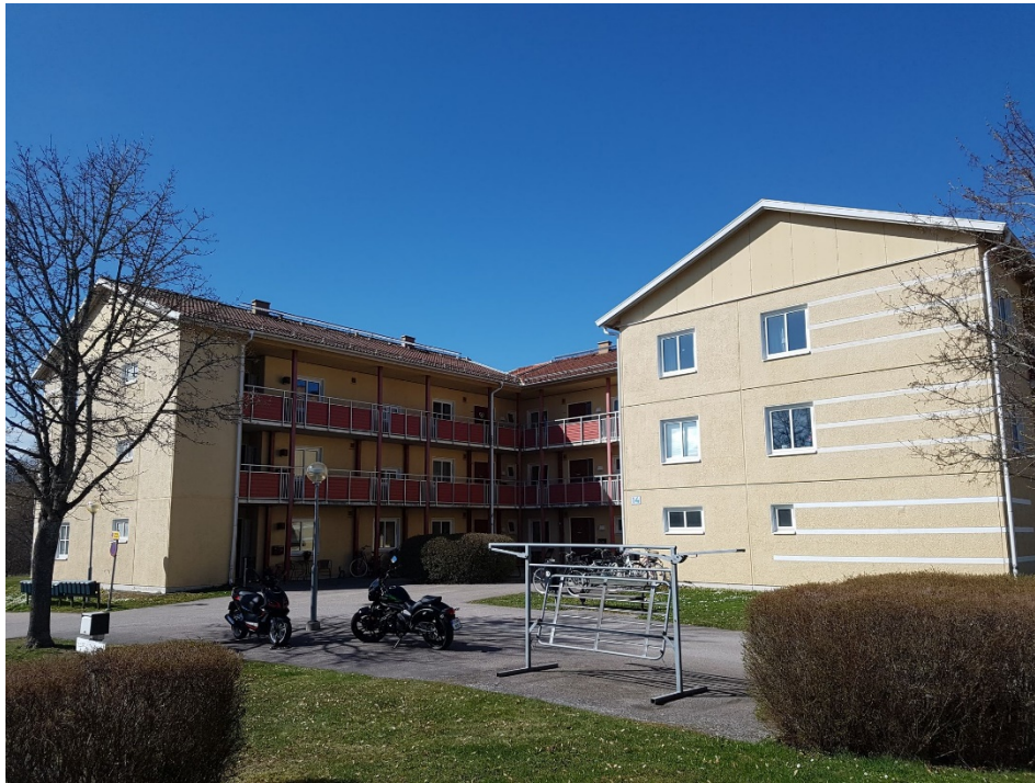
Figur 2 Foto på flerbostadshusen byggda i betong
