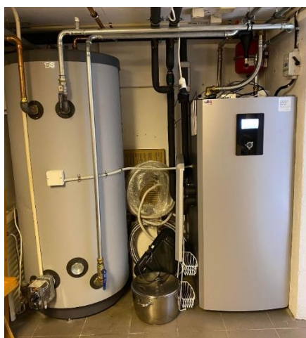
Figur 13. Akkumulatortank (vänster) med timprisstyrd värmepump (höger).
